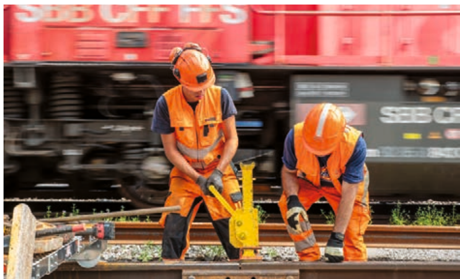
➤ Malik De Santis und sein Kollege verbinden zwei Gleisstücke mit einer Lasche. Dazu heben sie das Gleis mithilfe einer Stockwinde in die richtige Position.
