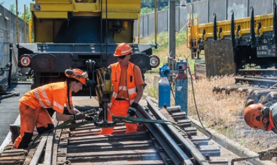
◀ Mirjam Huemer und ihre Kollegen befestigen die schweren Gleisstücke am Schienenkran.
