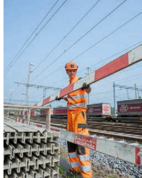
➤ Bevor die Gleisarbeiten beginnen, sichert der Gleisbauer die Baustelle mit Absperrschranken.
